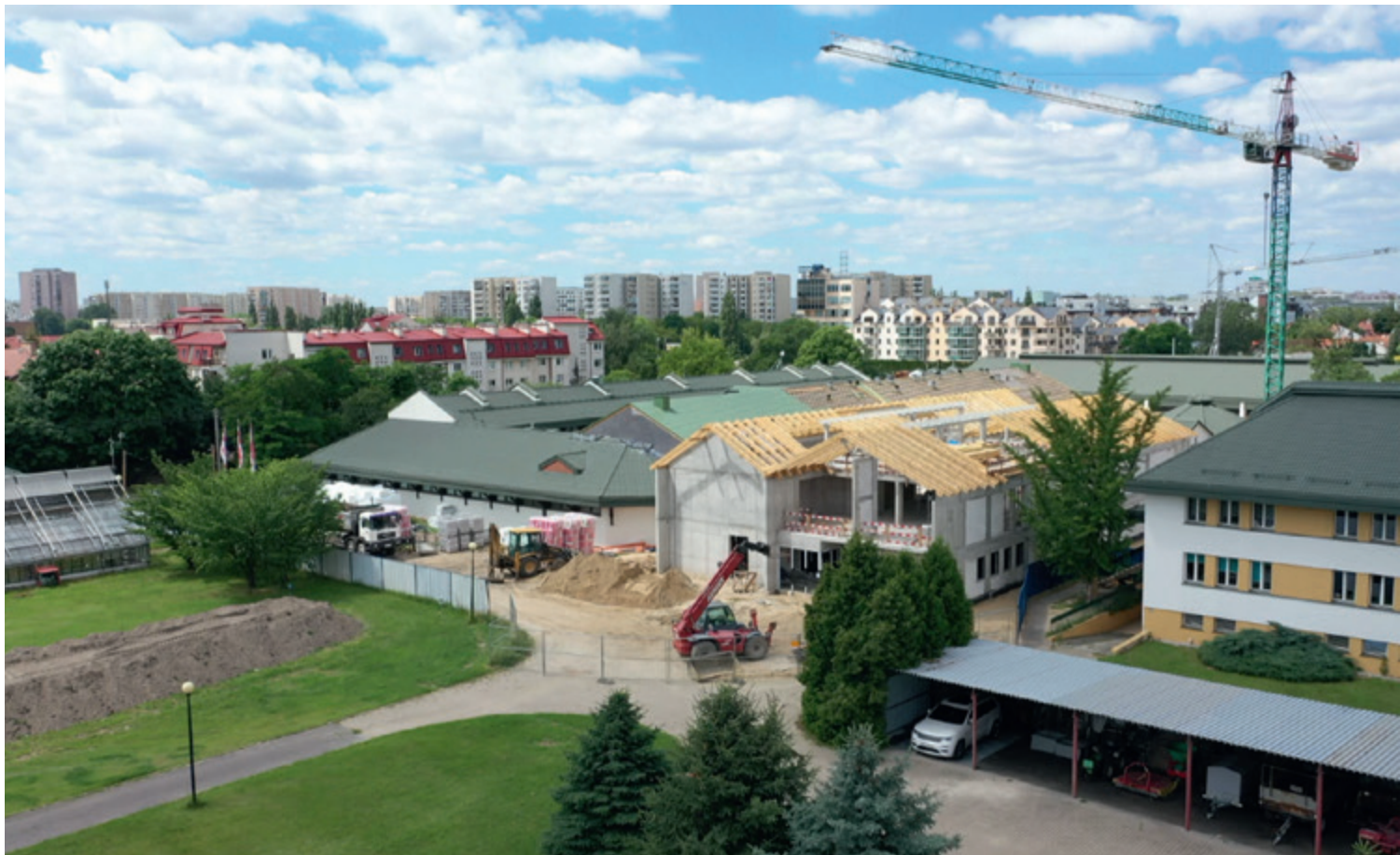
Budowa Centrum Medycyny Regeneracyjnej SGGW
